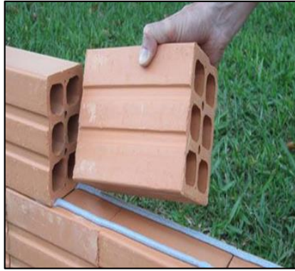
FIGURA 1: Uso de adesivos na construção civil [2].
