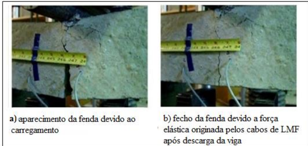
FIGURA 9: Aplicação de fios LMF pseudoelásticos para recuperação de forma de uma estrutura civil de teste fissurado devido ao carregamento [14].
