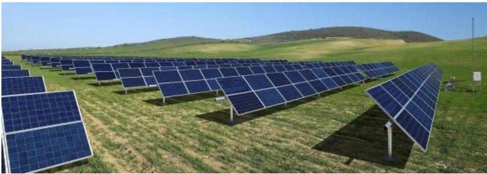
*Figura 5: Exemplo de parque solar utilizando seguidores solares*
