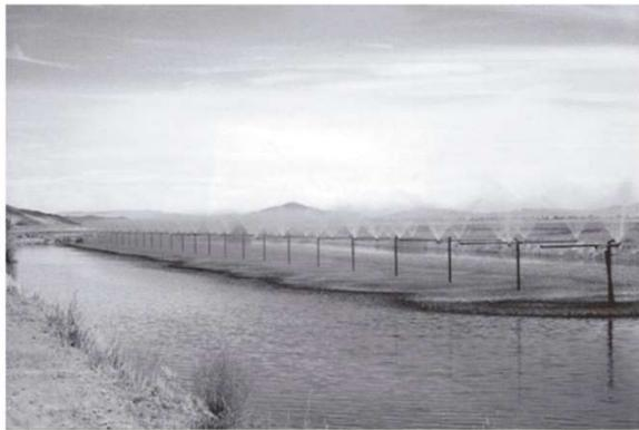
**FIGURA 14–33** Uma lagoa de resfriamento de água por pulverização.
